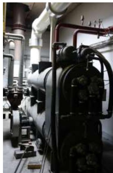
Par ailleurs, le dispositif de refroidissement des effluents, affecté par des problèmes de corrosion devra être réparé voire remplacé et la très grande fragilité
